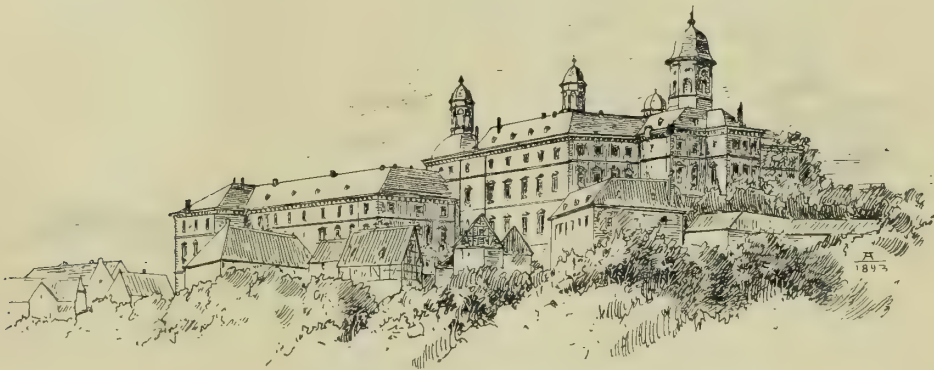
Fig. 33. Bensberg. Gesamtansicht des neuen Schlosses.
